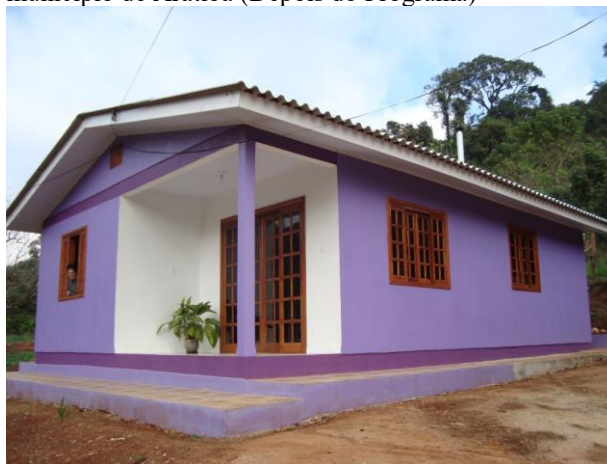
Figura 4 – Residência localizada no interior do município de Aratiba (Depois do Programa)
