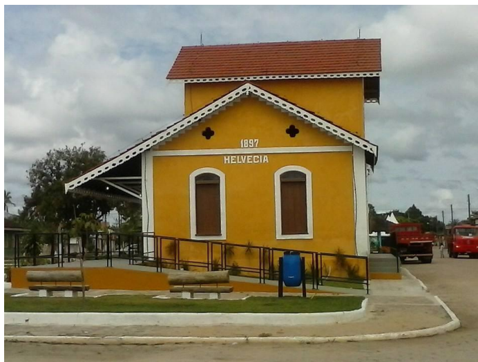
Figura 1. Estação de trem da ferrovia Bahia-Minas. Foto: João Paulo de O. Santos, 2013
