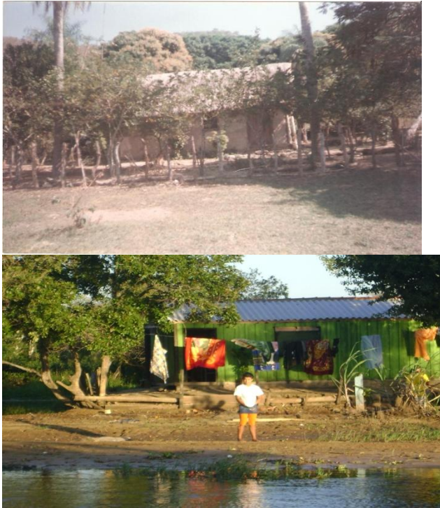
Figura 4: Moradia tradicional (pau-à-pique e palha) pantaneiro-ribeirinha na Comunidade do Amolar (acervo do autor, 1999) e moradia feita com tábuas aplainadas e telhas de amianto na Comunidade do Paraguai-Mirim (acervo do autor, 2011).
