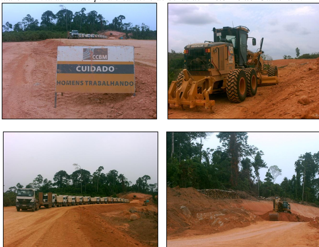
Quadro 02- Via de acesso para o canteiro de obras de “Belo Monte- Outubro/2011
