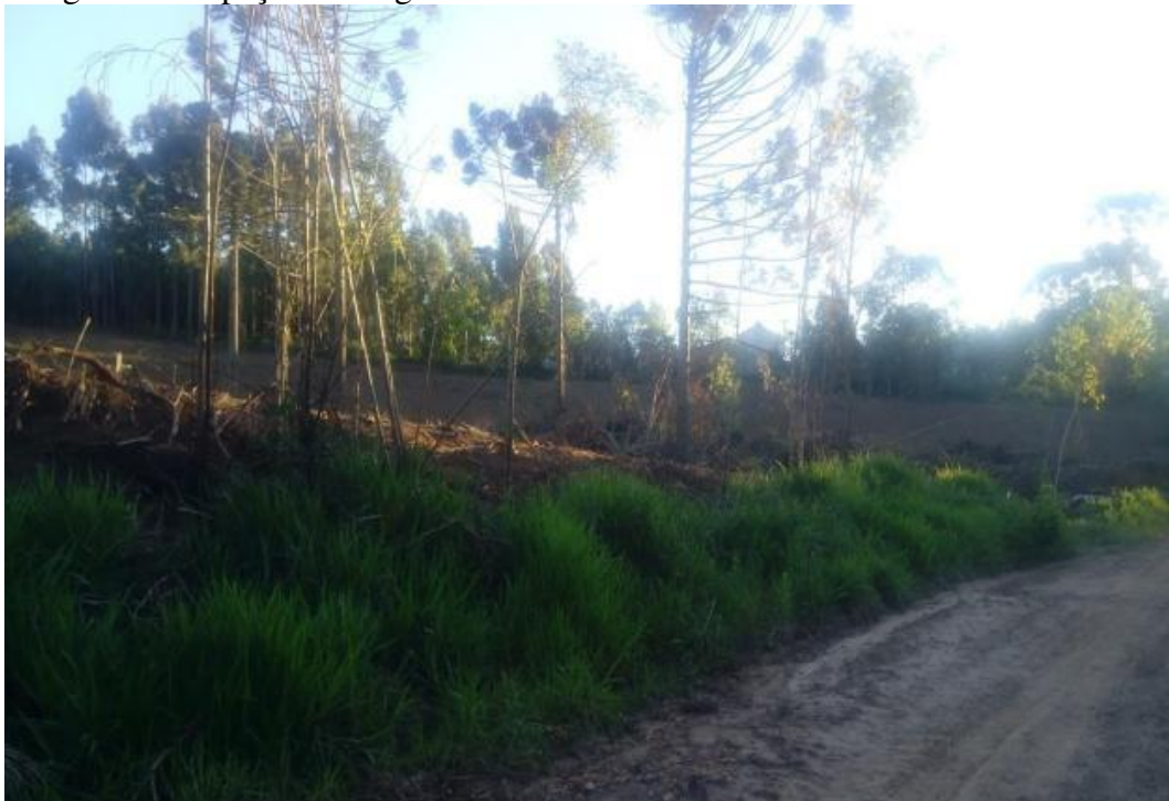
Imagem 05: Espaço do antigo criadouro sendo destocado - 2017.
