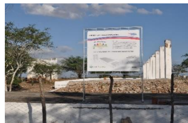
Assentamento Vitória: Sistema coletivo de captação e armazenamento de água de chuva, com capacidade de 260 mil litros de água. Reforma realizada pela comunidade e participação efetiva de todos os parceiros.
