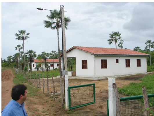
Foto 1: Casas de alvenaria
